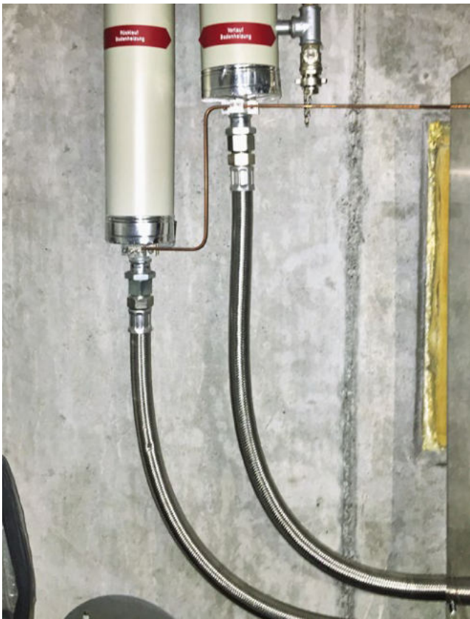
[ABB. 1] Wärmepumpe mit nicht sauerstoffdichten EPDM-Anschlüssen.
