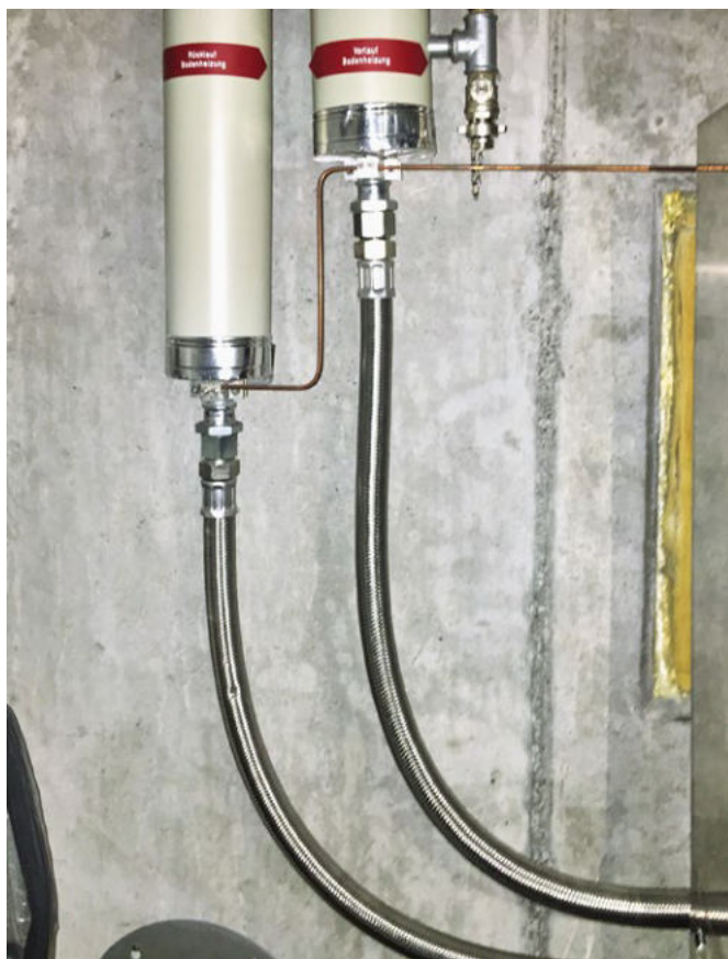
[FIG. 1] Pompe à chaleur avec raccords EPDM non étanches à l'oxygène.
